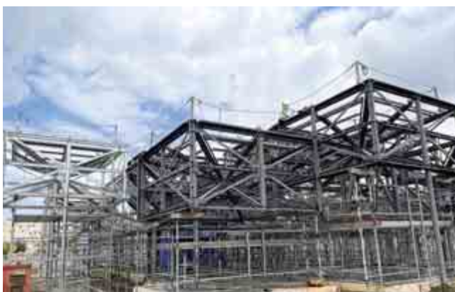
▲ キューブ型屋根の組立てが進む建設現場
