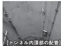
[トンネル内頂部の配管]
