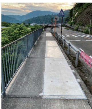
補修工事が完了した通学路
