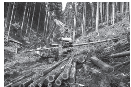
大型機械による作業
