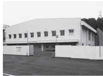
大飯中学校体育館
