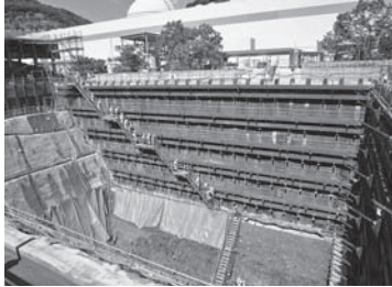
F6破砕帯トレンチ
